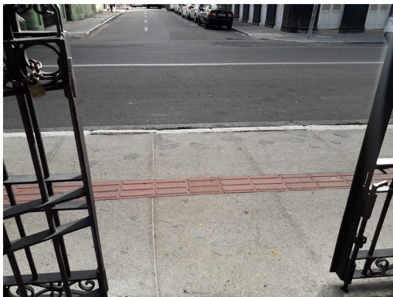
Figura 1-localizado na rua Dtr João Moreira, esse portão não possui rampa de acesso. Fonte: acervo da autora
