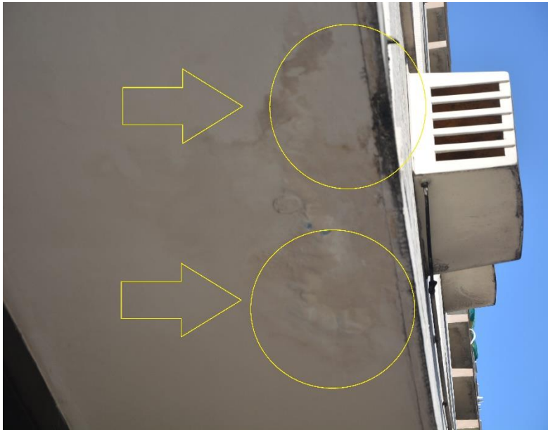
Figura 2 - Infiltrações
