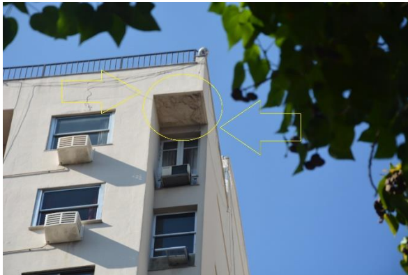
Figura 2 - Infiltrações
