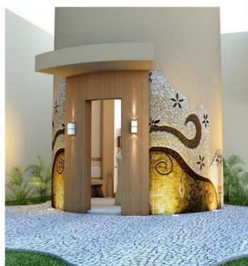
Imagem 03 - Obras Capela do Hospital 13 de Maio de Sorriso-MT
